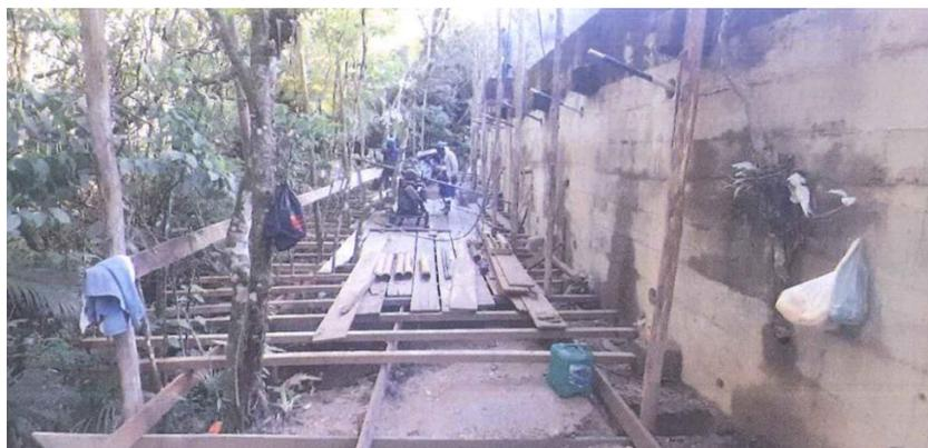
**Foto 5** – Reforço no Muro de Contenção – Km 063+000
